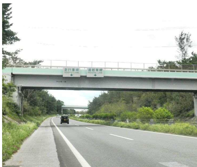
沖縄自動車道を跨ぐ橋梁 (141号線 中山第一橋 側面)
